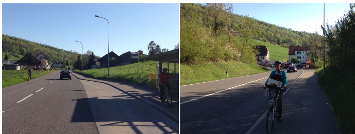
Abbildung 11: fehlende Velo-Massnahmen entlang der Landstrasse bei der Haltestelle Breitwies (Bild links) und im Höhtal (Bild rechts, Velos fahren auf Trottoir)
