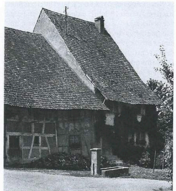
Abb. 161 Unterehrendingen. Haus Oberdorf Nr. 7. Wohntrakt (rechts) 1695, Stallscheune 18. Jb. Ansicht von Südosten. Aufnahme 1971.
